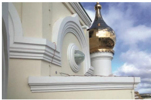
Рис.12 Трубочатый светодиод на фасаде
